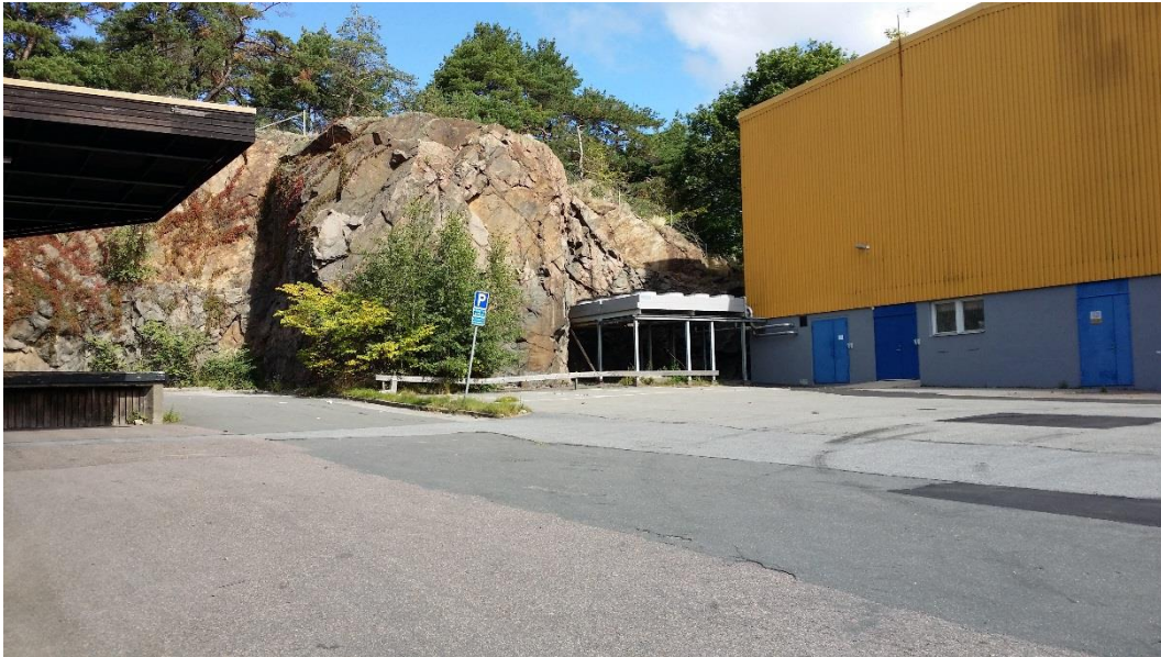
Figur 5.5. Vy nedanför ID 3 där ingen synlig bergförstärkning syns bakom befintliga byggnader.
