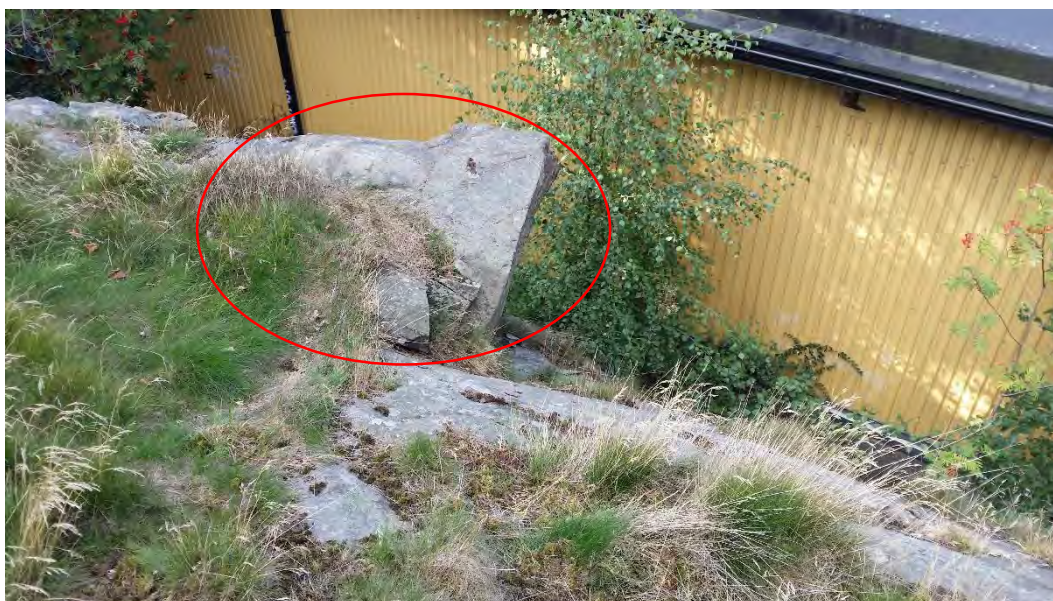
Figur 10 Vy från ID 5, löst block ner mot befintlig byggnad
