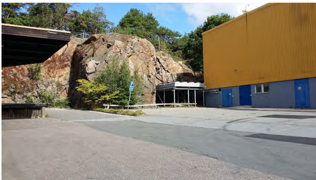
Figur 7 Vy nedanför ID 3 där ingen synlig bergförstärkning syns bakom befintliga byggnader
